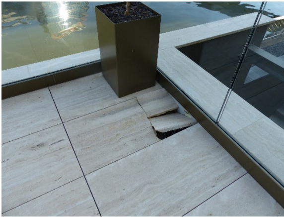
Bild 8: Belag mit 6 Stelzlager
