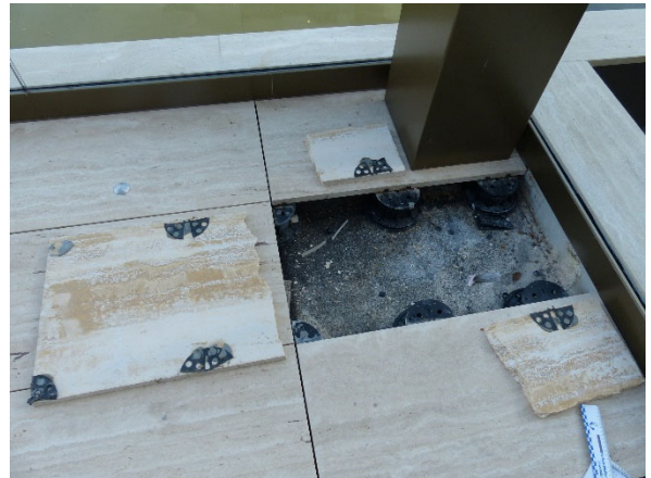
Bild 9: Belag mit 6 Stelzlager
