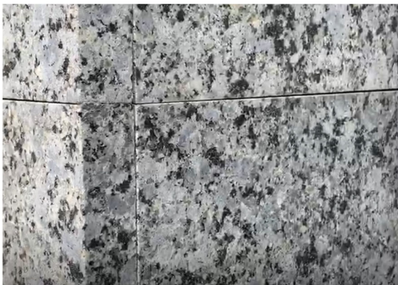
Bild 11: gleichmäßige Pressfuge
