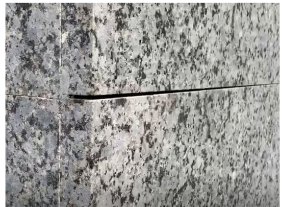
Bild 12: mangelhafte Pressfuge
